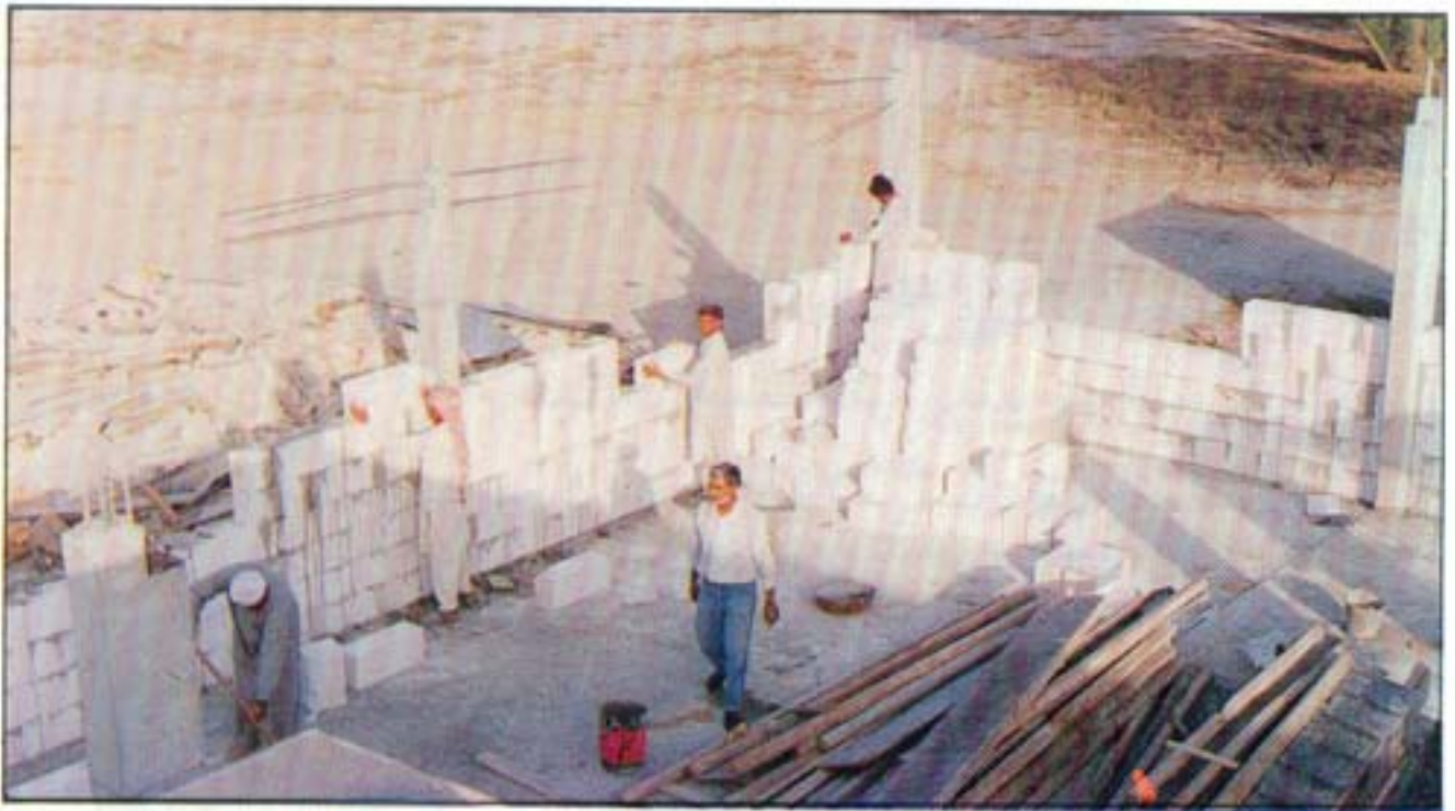
❖ أعمال البناء في توسعة المقر الحالي للجمعية ❖
